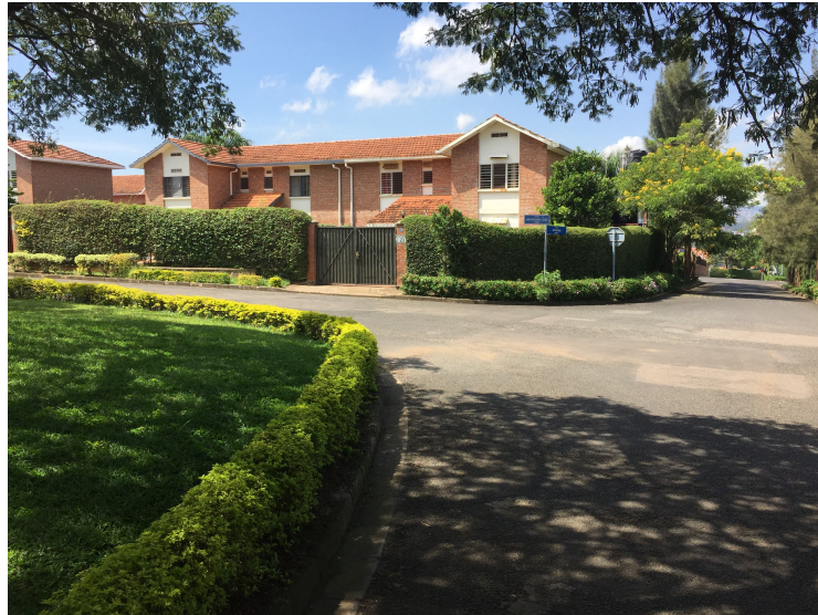
Fig 7. Foto delle case binate nell'insediamento Kigali 2020, 2005 [Foto Manlio Michieletto, 19/04/2022]
